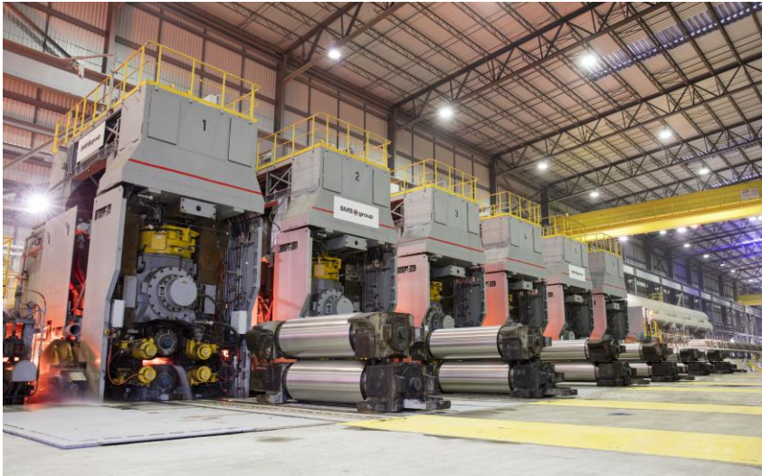
CSP® hot rolling mill.
